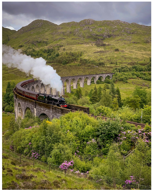
图：格伦芬南高架桥
